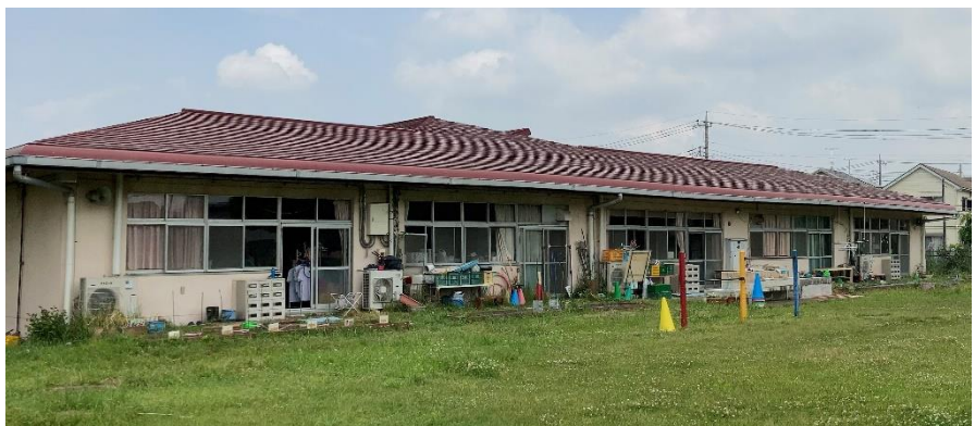
工事前の小学部棟 この姿も見納めです
